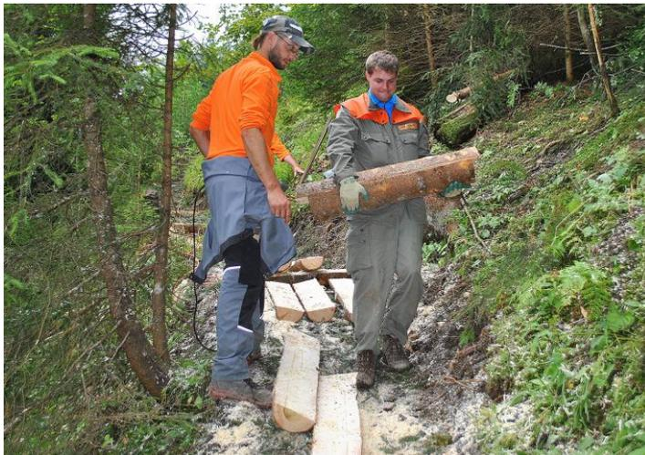
Auf einem Wegstück mit rund 350 Metern Höhendifferenz wurden insgesamt 900 Holztritte verlegt. Die Hälfte davon waren vorgefertigte Eichenholzelemente, die andere Hälfte wurde von Zivilschutzspezialisten vor Ort angefertigt. Die bis zu 25 Kilo schweren Holzschwelen mussten von den Zivilschützern von Hand aus den Holzdepots an die Arbeitsplätze getragen werden. Die zum Teil heftigen Regenfälle während den beiden Einsatzwochen machten das steile Gelände sehr rutschig, so dass die Arbeiten unter
