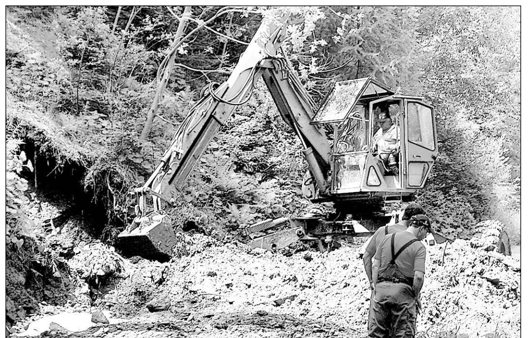
Vor allem bei der Hangsanierung auf der Forststrasse in den Ifil, aber teilweise auch auf den Wanderwegen wurde der Einsatz von kleineren und grösseren Baumaschinen nötig.
