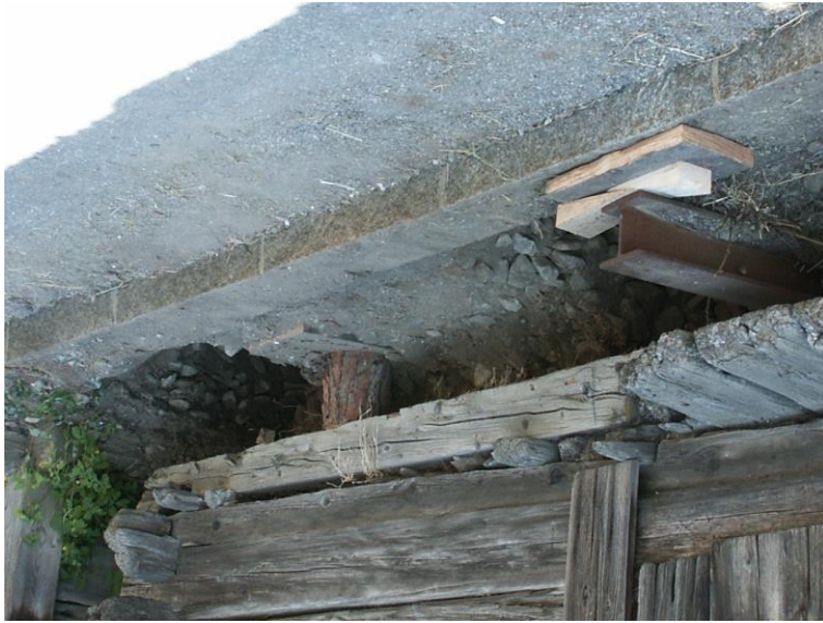
Provisorische Unterstellung: Lärchenstamm und H-Träger.
