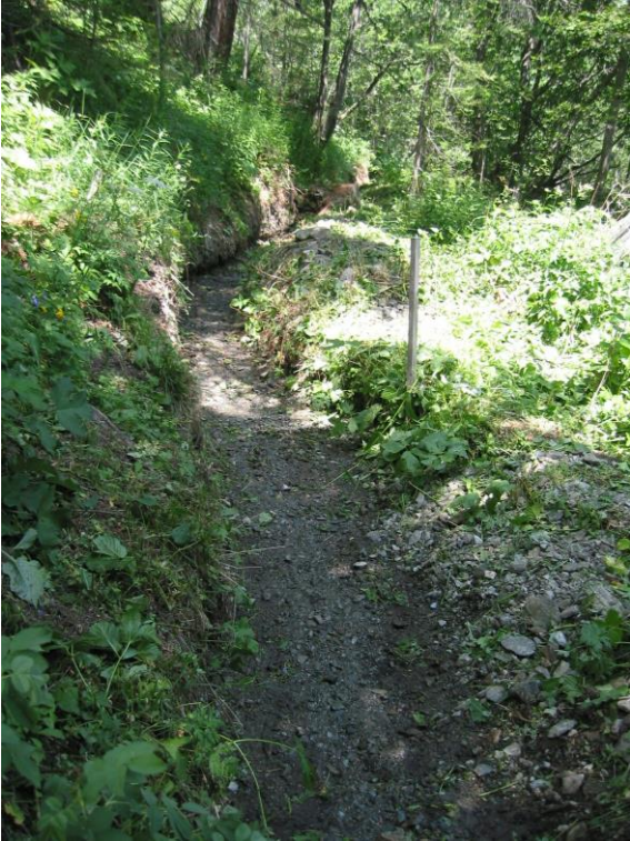
Suonenbett nach der Ausbesserung.
