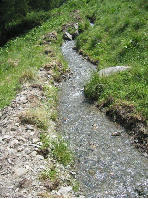
Die alte Suon nach der Räumung.
