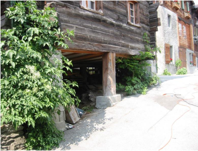
Alter Zustand der verschiedenen Pfosten (Mauerwerk und Holzpfeiler)
