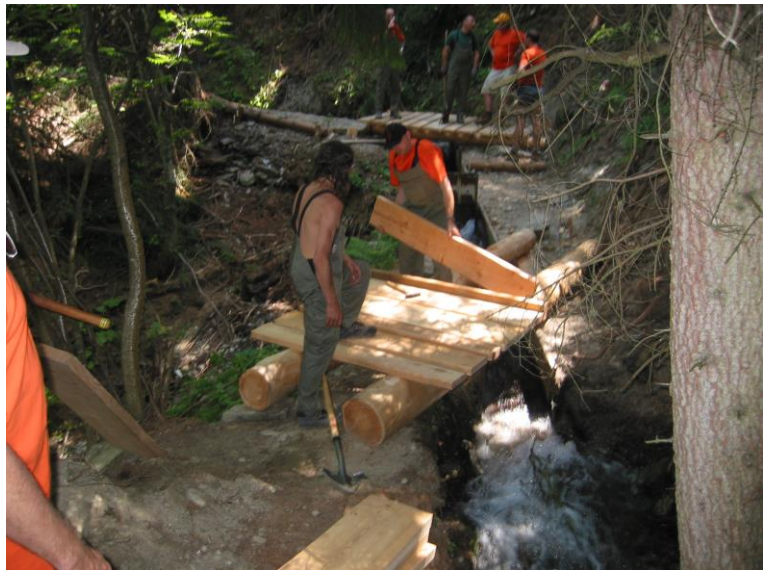
Beim Bau der zwei Brücken bei der Abzweigung der „Alten Suon“ und des Breirtüss.
